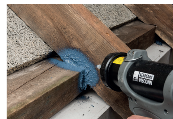
Durchdringungen einbinden innen und außen
