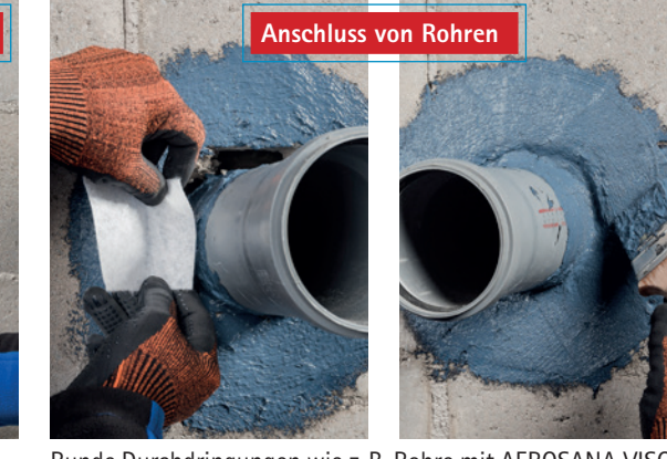
Verschließen von Löchern bis max. 70 mm Durchmesser
