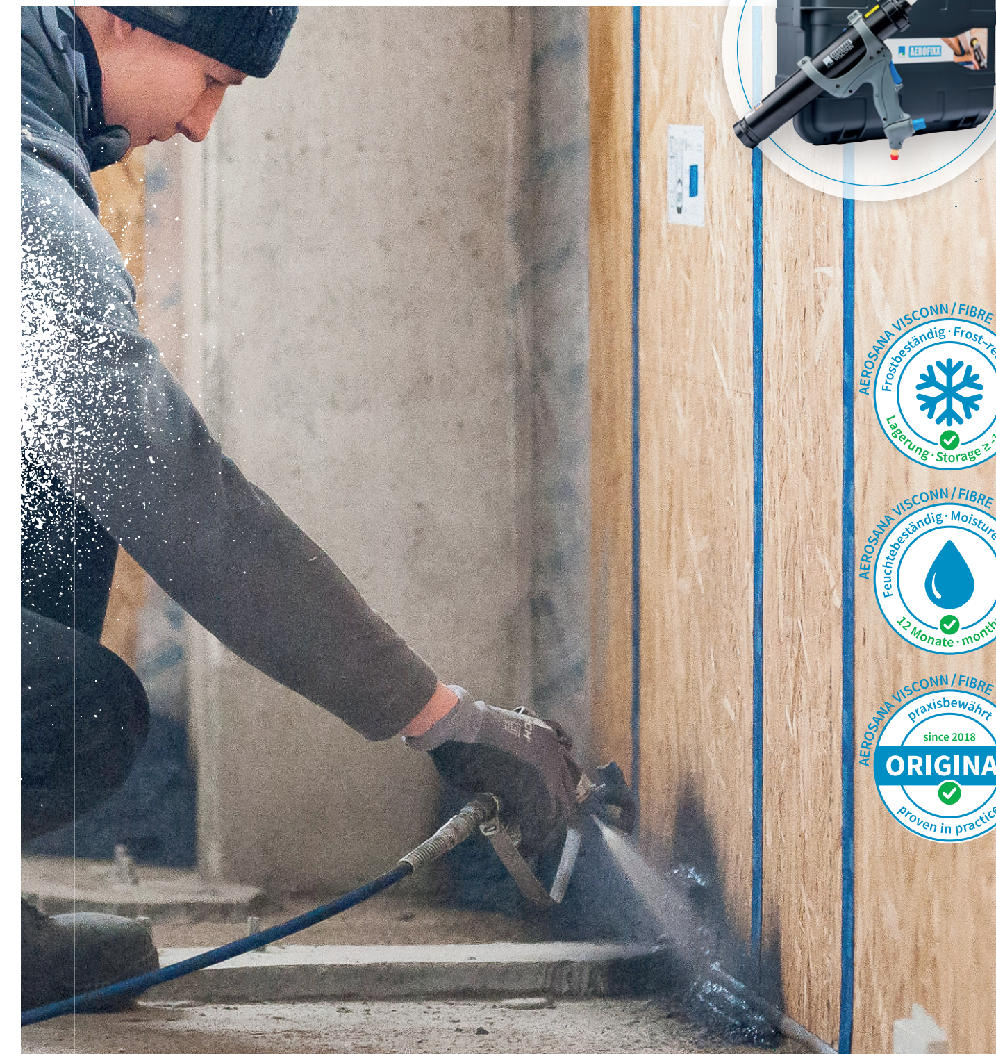
AEROFIXX Auftragswerkzeug für Schlauchbeutel im AEROSANA-System
