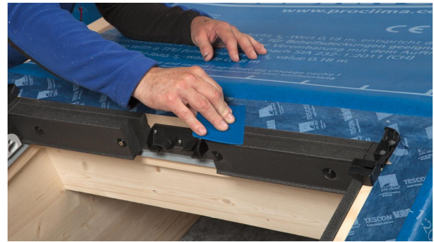
26. Gebruik TESCON VANA om alles te fixeren.
