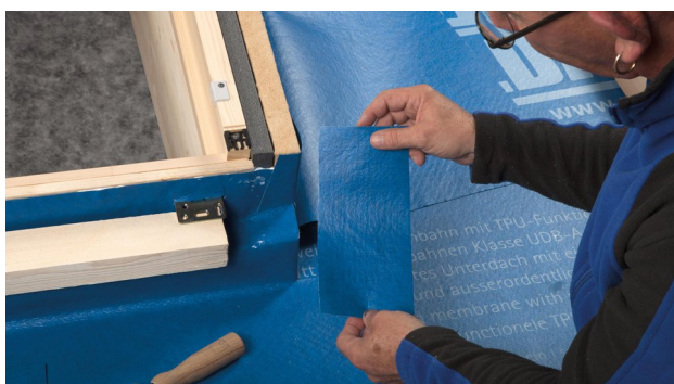
11. Snijd een stuk SOLITEX WELDANO-S van ca. 15 tot 20 cm lang en ca. 10 tot 12 cm breed uit om de lassen bij de hoek te bedekken.
