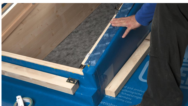
23. Gebruik TESCON VANA om alles te fixeren.
