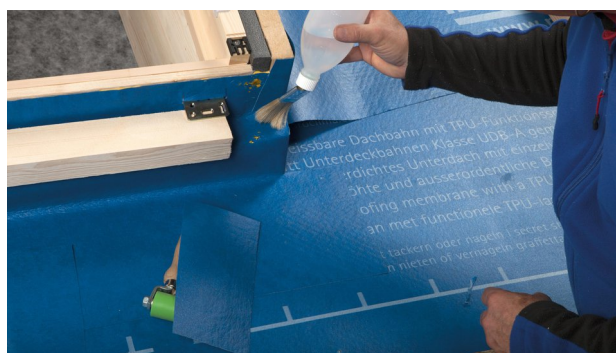
12. Las het stuk bij de hoek aan de onderrand van het kozijn/isolatieframe vast.
