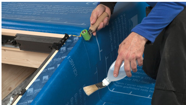
25. Las de stroken SOLITEX WELDANO 3000 aan de zijkant aan elkaar.
