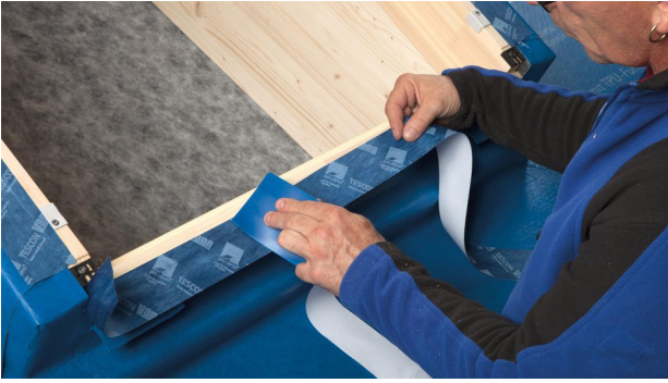
33. Gebruik TESCON VANA om alles te fixeren.
