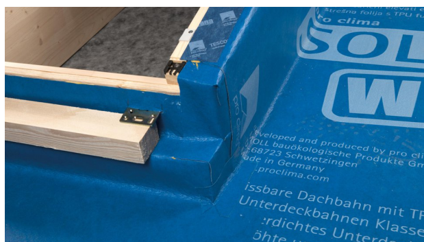
30. De hoek is nu afgedicht.
