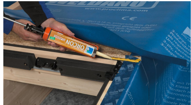
24. Verlijm SOLITEX WELDANO 3000 met ORCON CLASSIC op de bovenste rand van het kozijn.
