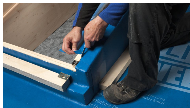
18. Snijd de strook parallel aan het kozijn af. Gebruik een lat als hulpmiddel om de strook zonder vouwen tegen de onderste rand te fixeren.
