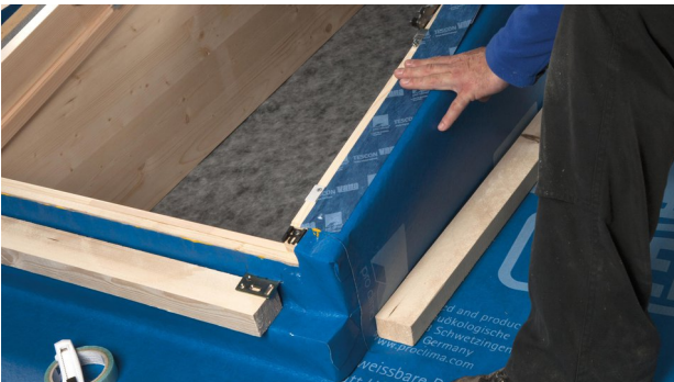
23. Gebruik TESCO VANA om alles te fixeren.
