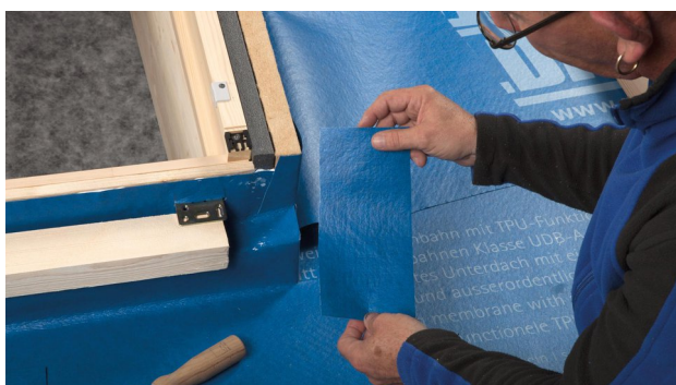
11. Snijd een stuk SOLITEX WELDANO-S van ca. 15 tot 20 cm lang en ca. 10 tot 12 cm breed uit om de lussen bij de hoek te bedekken.
