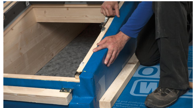
22. Verlijm SOLITEX WELDANO 3000 op de zijkant van het kozijn. Leg de folie met een uitzettingslus in de lijmlaag. Druk de lijm daarbij niet helemaal plat, zodat bewegingen kunnen worden opgevangen.
