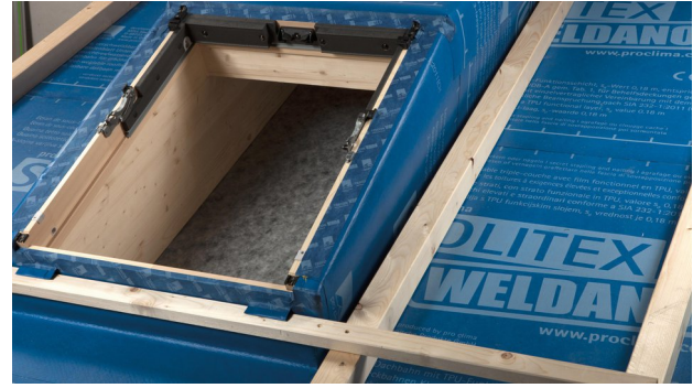
34. Monteer de tengellatten en steunlatten en schroef de montagehoeken vast. Klaar.
