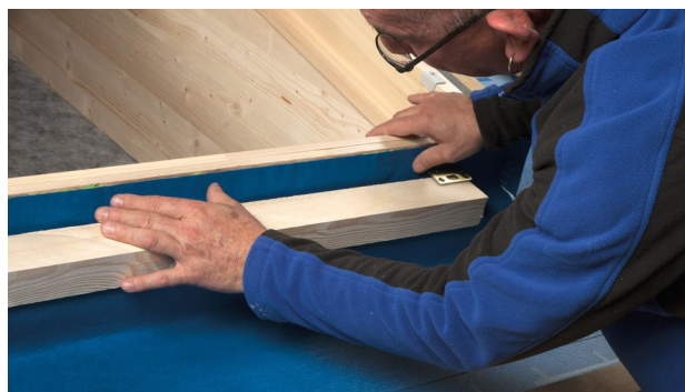
8. Leg SOLITEX WELDANO-S 3000 met een uitzettingslus in de lijmlaag. Druk de lijm daarbij niet helemaal plat, zodat bewegingen kunnen worden opgevangen.
