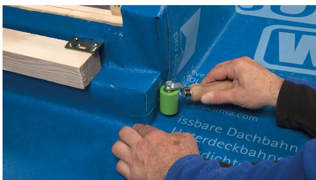
29. Las het stuk SOLITEX WELDANO 3000 vast.
