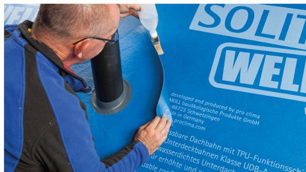
**11a. Raccord à des passages de conduits – cas de toits inclinés :**
