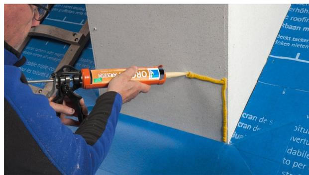
**13a. Pour les toitures fortement inclinées : raccord à des éléments de construction ascendants (p. ex. une cheminée)**
