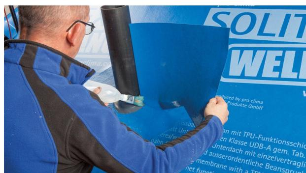
**11c. Raccord à des passages de conduits – cas de toits inclinés :**
