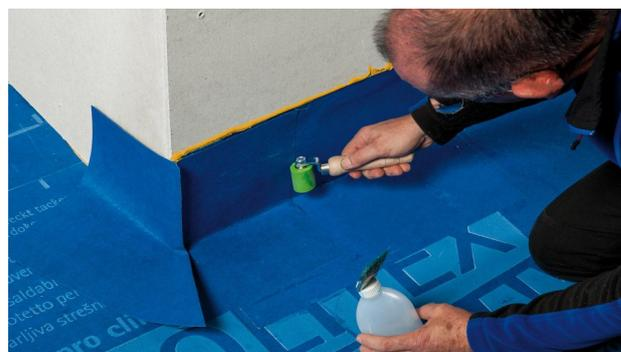
**12a. Raccord aux éléments de construction sortants (p. ex. : cheminée) – cas de toits à très faible pente**
