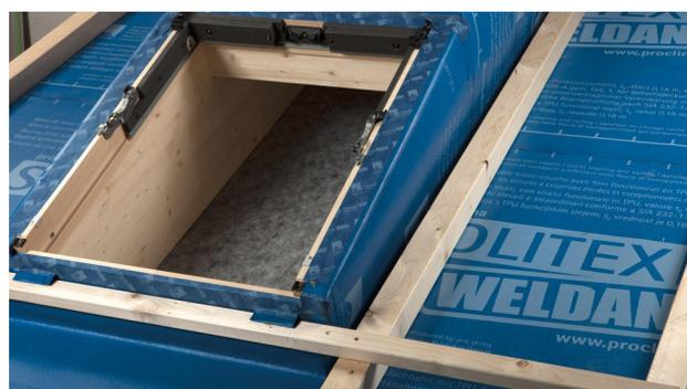
**16. Raccord à une fenêtre de toit**
