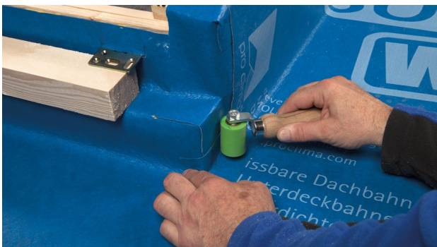
29. SOLITEX WELDANO 3000 Streifen anschweißen.
