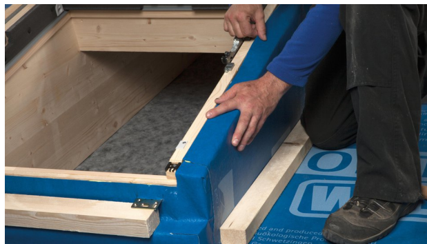
22. SOLITEX WELDANO 3000 entlang der Rahmenkante verkleben. Bahn mit Dehnschleife in das Kleberbett legen. Kleber dabei nicht ganz flach drücken, damit ggf. Bewegungen aufgenommen werden können.
