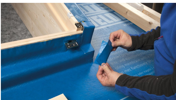
31. Hilfs-Tragplatte entfernen und Passtücke zum einkleben der Montagewinkel zuschneiden.
