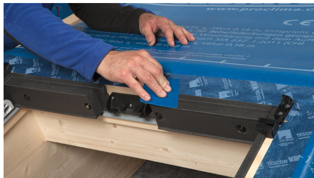
26. TESCO VANA zur praktischen Montage-Fixierung verwenden.
