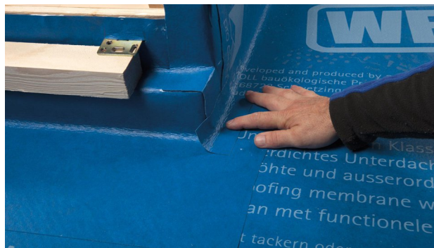
28. Auf wasserführende Bahnenüberlappung achten.
