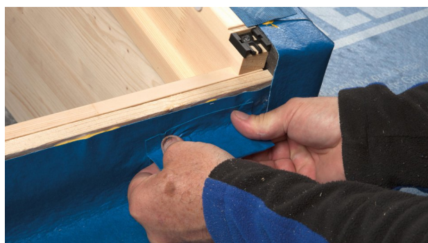
32. Montagewinkel einschweißen.
