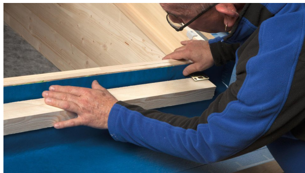
8. SOLITEX WELDANO-S 3000 mit Dehnschleufe in das Kleberbett legen. Kleber dabei nicht ganz flach drücken, damit ggf. Bewegungen aufgenommen werden können.
