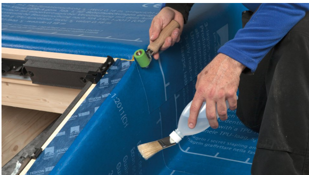
25. Seitlich die Lagen SOLITEX WELDANO 3000 miteinander verschweißen.
