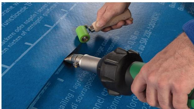
**5b. Alternativ: Überlappung verschweissen mit Heissluftgerät**
