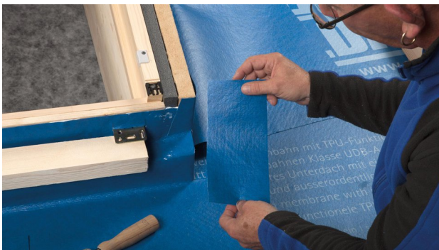
11. Ein Passstück zur Überdeckung der Einschnitte im Rahmen-Eckbereich zuschneiden. Ca. 15 bis 20 cm lang und ca. 10 bis 12 cm breit.
