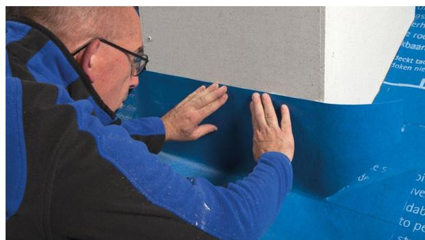
**12b. Bei Steildächern: Anschluss an aufgehende Bauteile (z. B. Schornstein)**
