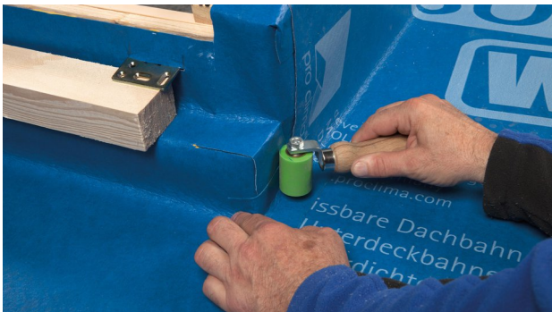
29. SOLITEX WELDANO 3000 Streifen anschweißen.
