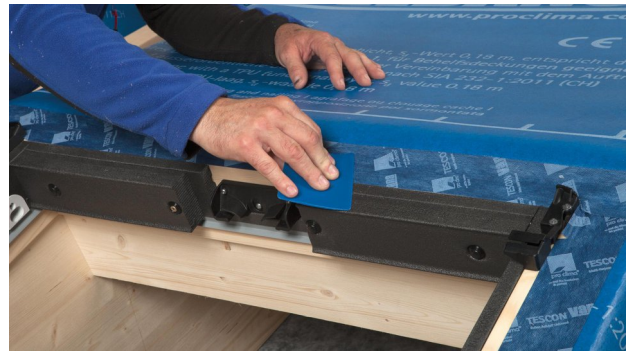
26. TESCO VANA zur praktischen Montage-Fixierung verwenden.
