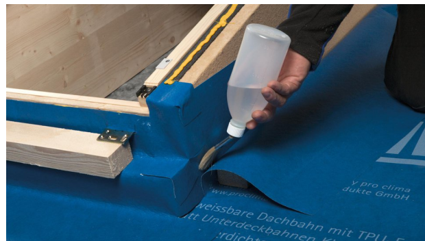
20. Unteren Eckbereich verschweißen.
