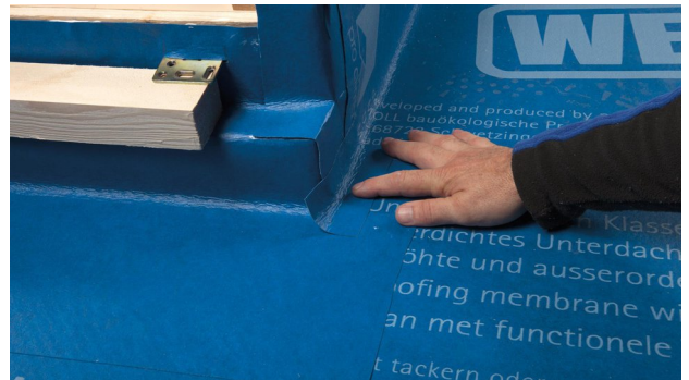
28. Auf wasserführende Bahnenüberlappung achten.
