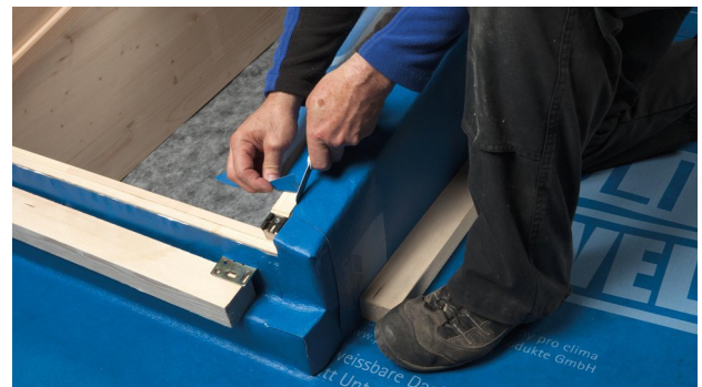
18. Parallel zum Fensterrahmen zuschneiden. Hierbei hilft eine Hilfsplatte zur faltenfreien Fixierung der unteren Kante.
