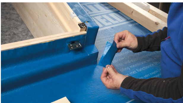
31. Hilfs-Traglatte entfernen und Passstücke zum einkleben der Montagewinkel zuschneiden.
