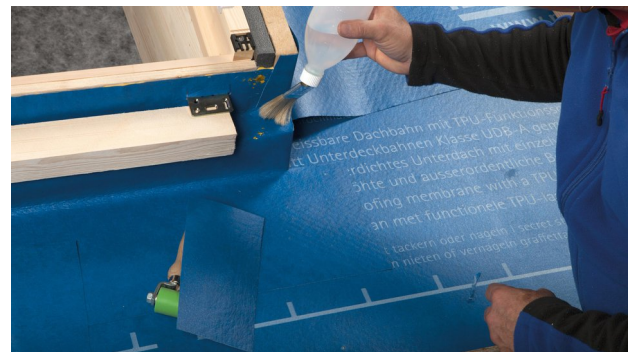
12. Passstück im Eckbereich an die Unterkante des Fensterrahmens/ Dämmrahmens aufschweissen.
