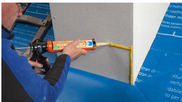
**12a. Bei Steildächern: Anschluss an aufgehende Bauteile (z. B. Schornstein)**
