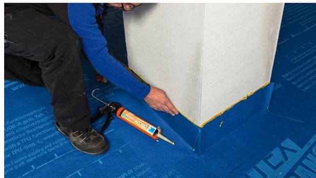
**11b. Bei flach geneigten Dächern: Anschluss an aufgehende Bauteile (z. B. Schornstein)**
