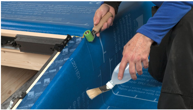
25. Seitlich die Lagen SOLITEX WELDANO 3000 miteinander verschweißen.
