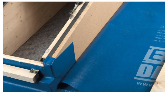
16. Fertige untere Eckabdichtung.
