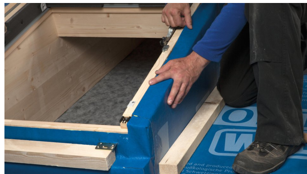
22. SOLITEX WELDANO 3000 entlang der Rahmenkante verkleben. Bahn mit Dehnschlaufe in das Kleberbett legen. Kleber dabei nicht ganz flach drücken, damit ggf. Bewegungen aufgenommen werden können.
