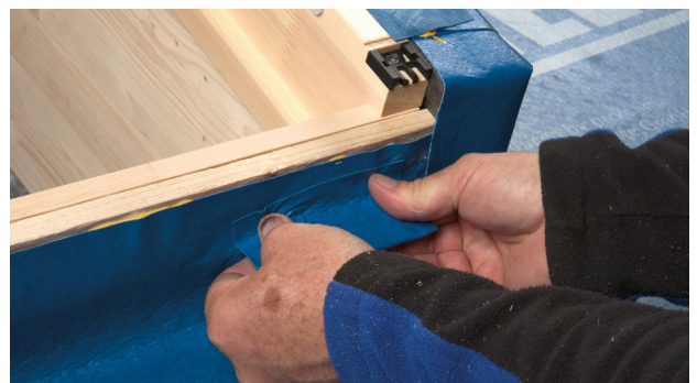
32. Montagewinkel einschweißen.
