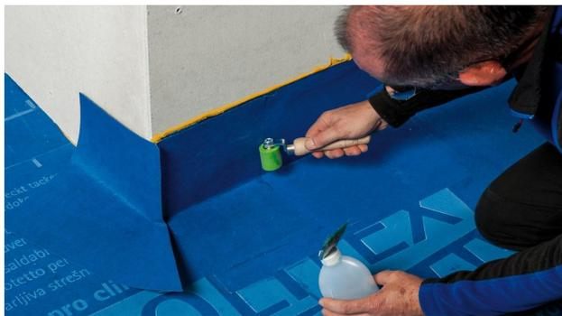
**11. Bei flach geneigten Dächern: Anschluss an aufgehende Bauteile (z. B. Schornstein)**
