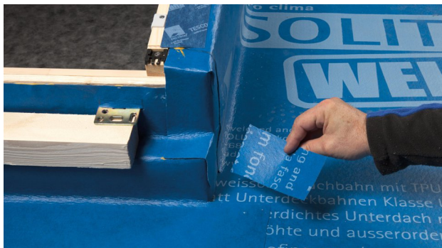
27. Snijd een klein stuk SOLITEX WELDANO 3000 uit om de lassen bij de onderste hoek te bedekken.
