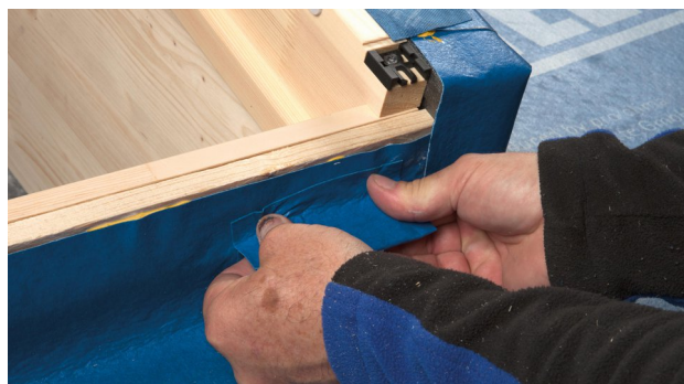
32. Las de stukken vast om de montagehoeken.
