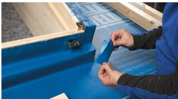
31. Verwijder de steunlat en snijd stukken om de montagehoeken af te dicht.
