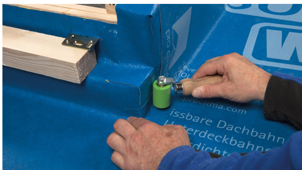
29. Las het stuk SOLITEX WELDANO 3000 vast.
