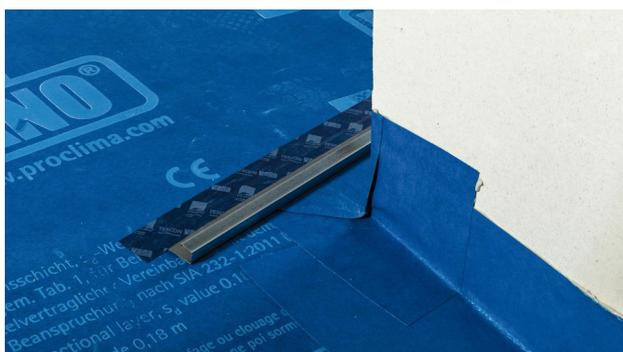
**13. Montaggio di una protezione per l'acqua**
