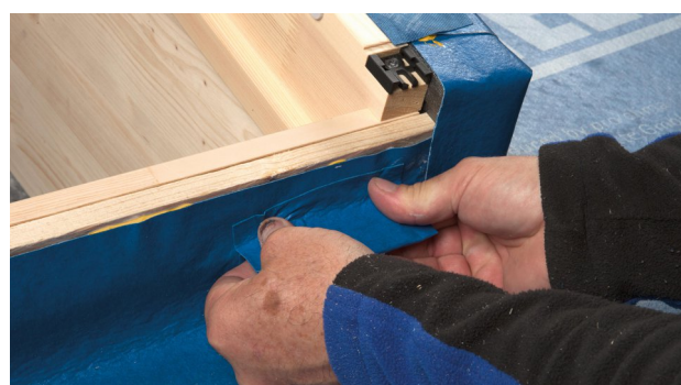
32. Souder ces bouts sur les équerres de fixation.
