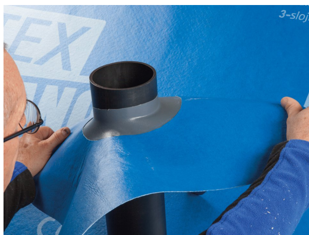
2. Réaliser le raccord Amener la manchette WELDANO ROFLEX PLUS par-dessus le conduit.
