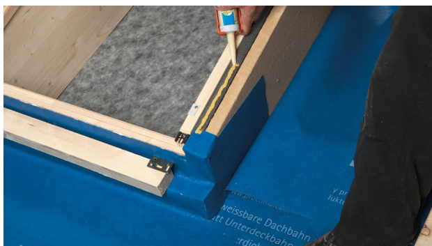
19. Appliquer un cordon de colle système ORCON CLASSIC d'un diamètre de 6 mm sur le châssis.
