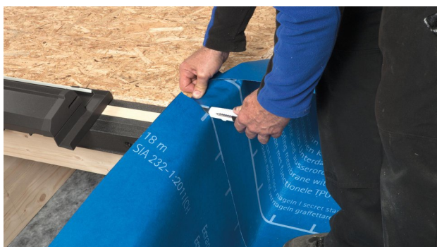
17. Faire remonter l'écran de la surface plane sur les flancs de la sous-costière. Alternative : couper à dimension un autre bout d'écran SOLITEX WELDANO-S 3000, le remonter sur la sous-costière et le souder en bas sur l'écran posé à plat.
