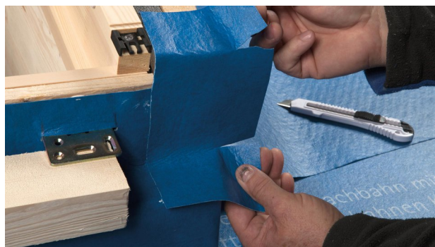
14. Entailler horizontalement le bout confectionné au niveau des deux bords. Au lieu d'entailler le bout jusque sur le châssis, laisser intacts quelques millimètres d'écran qui garantiront l'étanchéité du coin.
