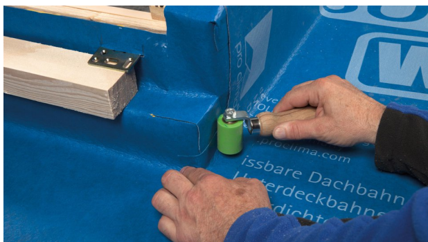
29. Souder la petite bande de SOLITEX WELDANO 3000.
