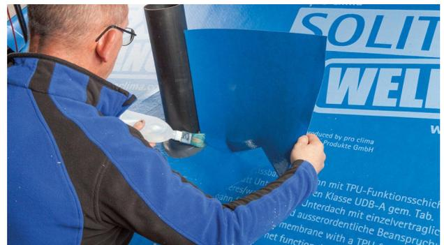
**11c. Raccord à des passages de conduits – cas de toits inclinés :**
