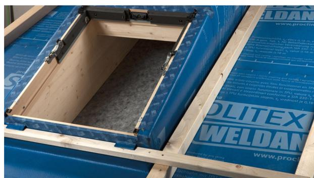
**16. Raccord à une fenêtre de toit**
