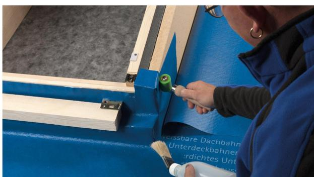
**15. Raccord à une fenêtre de toit**
