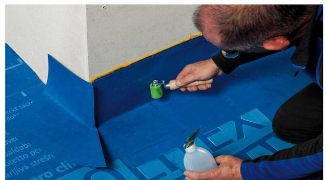
**12a. Raccord aux éléments de construction sortants (p. ex. : cheminée) – cas de toits à très faible pente**
