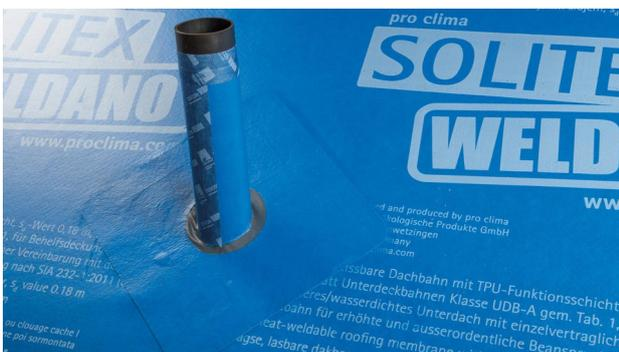
**11d. Raccord à des passages de conduits – cas de toits inclinés :**
