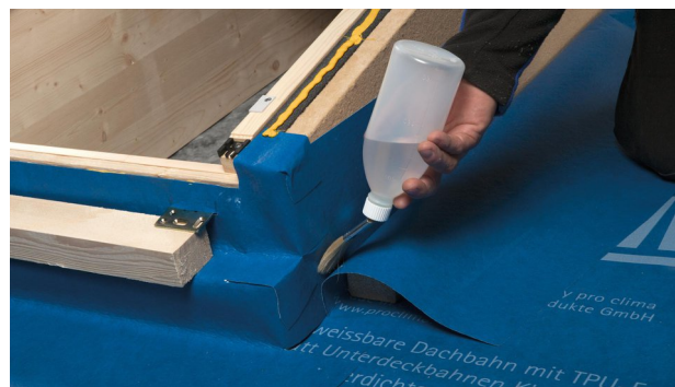
20. Unteren Eckbereich verschweißen.
