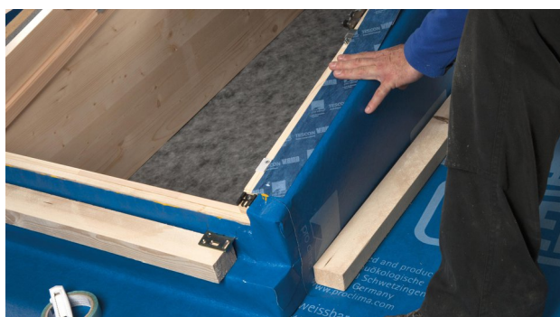
23. TESCON VANA zur praktischen Montage-Fixierung verwenden.
