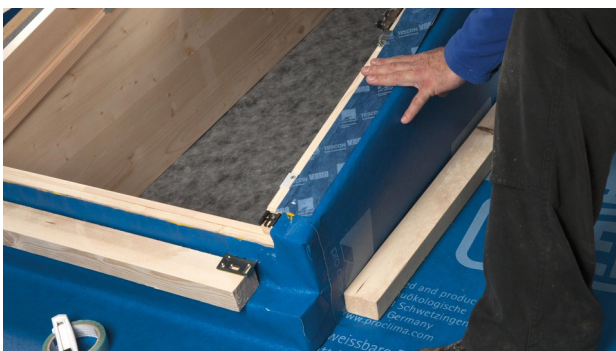
23. TESCON VANA zur praktischen Montage-Fixierung verwenden.
