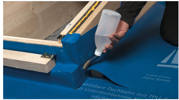
20. Unteren Eckbereich verschweißen.
