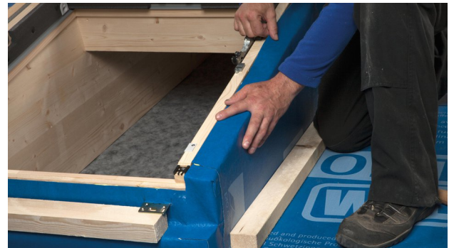
22. SOLITEX WELDANO 3000 entlang der Rahmenkante verkleben. Bahn mit Dehnschlaufe in das Kleberbett legen. Kleber dabei nicht ganz flach drücken, damit ggf. Bewegungen aufgenommen werden können.
