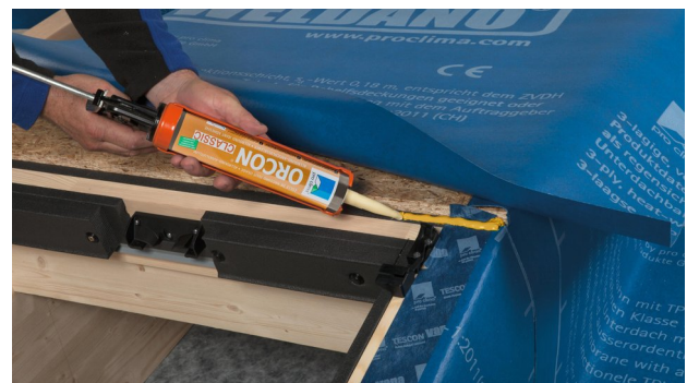
24. Flächige SOLITEX WELDANO 3000 mit ORCON CLASSIC am oberen Fensterrahmen verkleben.
