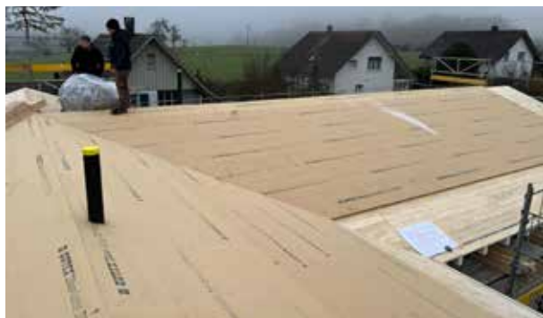
Levering van de geconfectioneerde folie voor montage op hout-vezelonderdakplaten
