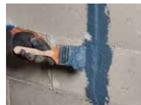
Rebouchage de fissures qu'à 20 mm
