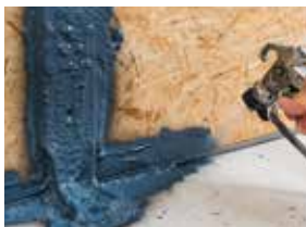
Anschluss Holzbauwände an Betonboden
