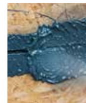
Verschließen von Rissen bis 3 mm
