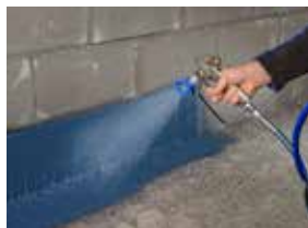
Dichten von unverputzten Wänden oder schadhaftem Putz
