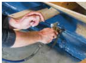
Anschluss an verputzte Schwelle
