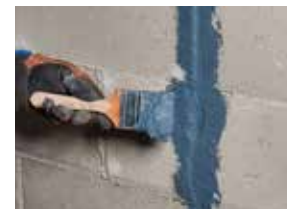
Zustreichen von Rissen bis 20 mm
