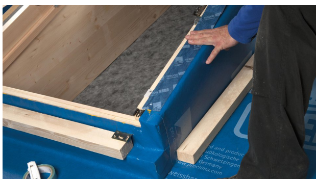
23. TESCON VANA zur praktischen Montage-Fixierung verwenden.
