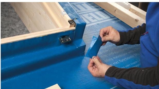
31. Hilfs-Traglatte entfernen und Passstücke zum einkleben der Montagewinkel zuschneiden.
