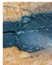
Verschließen von Rissen bis 3 mm
