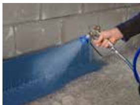
Dichten von unverputzten Wänden oder schadhaftem Putz
