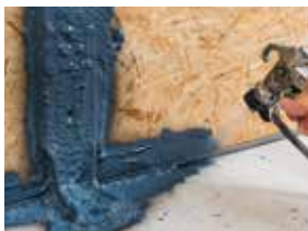
Anschluss Holzbauwände an Betonboden
