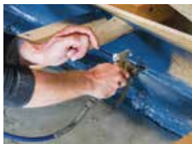
Anschluss an verputzten Drempel
