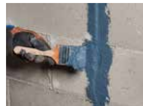
Zustreichen von Rissen bis 20 mm
