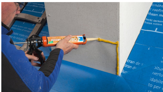
2a. Bei Steildächern: Anschluss an aufgehende Bauteile (z. B. Schornstein)
