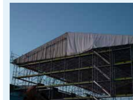
Abb. 3: Einhausen bzw. Notdach
