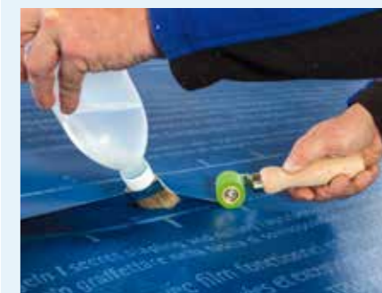
Abb. 21: Verschweißung von Unterdeckbahnen, mittels Quellschweißmittel oder Heißluftföhn werden die Funktionsschichten überlappender Bahnen homogen verschweißbar
