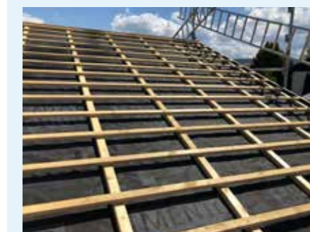
Abb. 4: Regensichernde Zusatzmaßnahme (hier verklebte Unterdeckbahn mit Nagel-dichtband)
