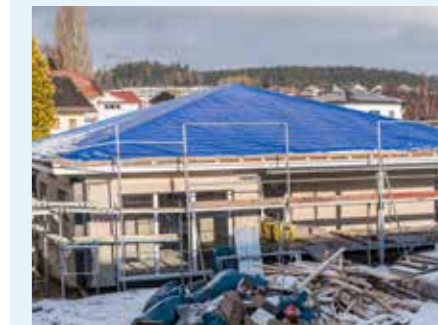
Abb. 2: Abplanen eines Daches
