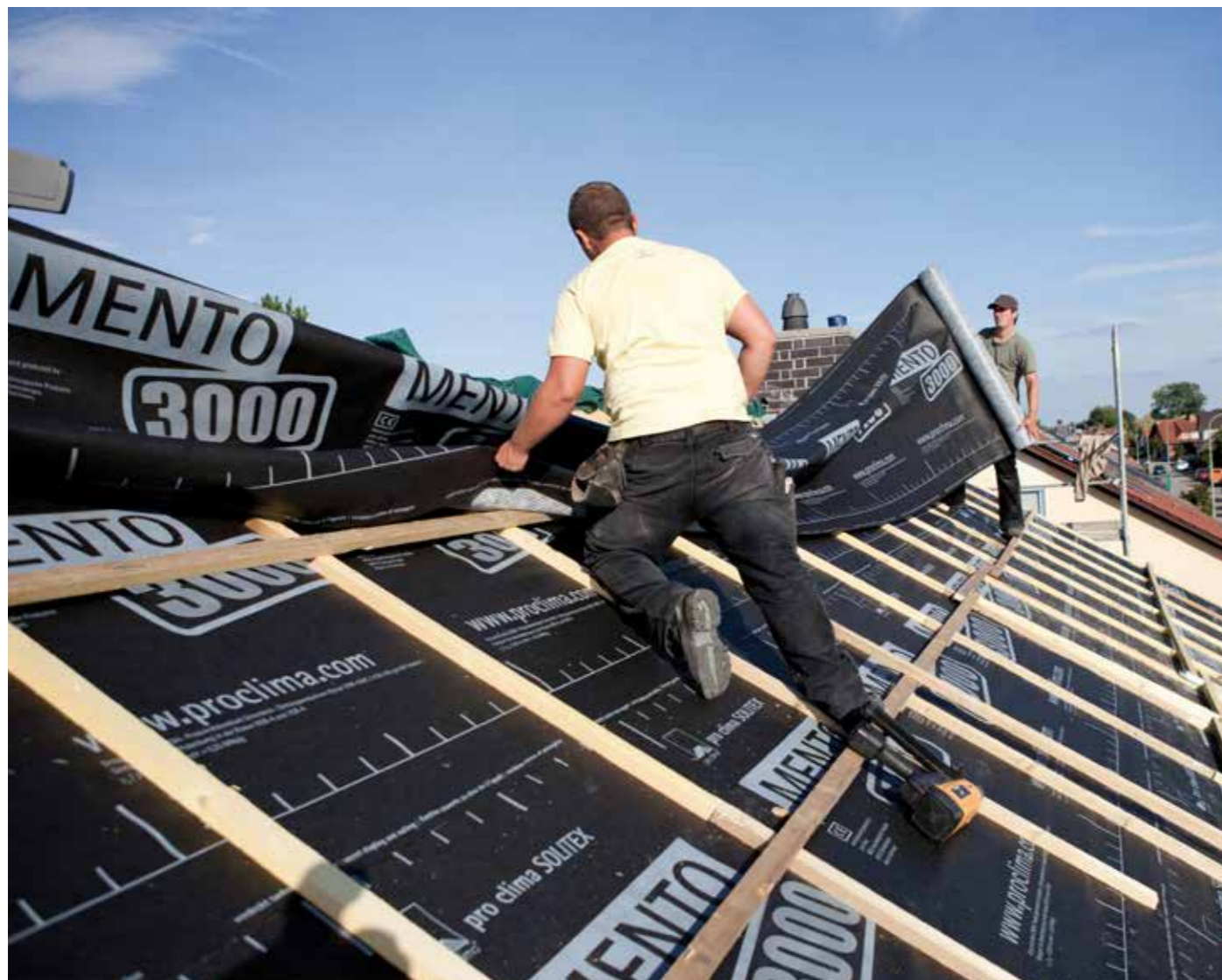
Abb. 1: Moderne Unterdeckbahn als Außendichtung unter späterer Eindeckung
