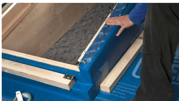
23. Gebruik TESCON VANA om alles te fixeren.
