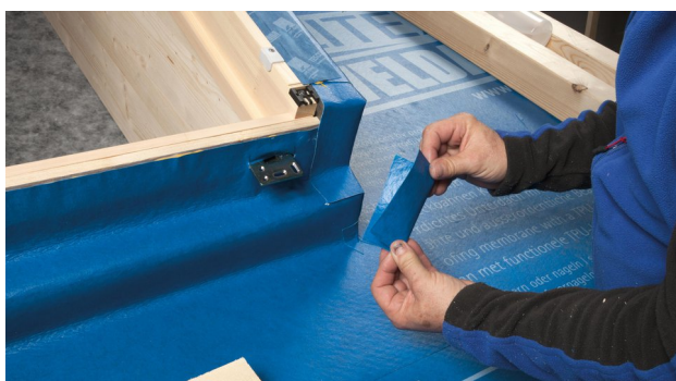
31. Verwijder de steunlat en snijd stukken om de montagehoeken af te dichten.
