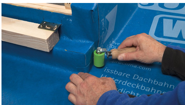
29. Las het stuk SOLITEX WELDANO 3000 vast.
