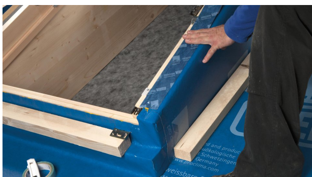
23. Gebruik TESCO VANA om alles te fixeren.
