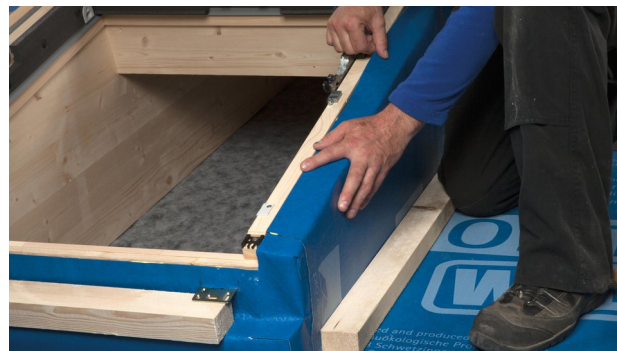
22. Incollare SOLITEX WELDANO 3000 lungo il bordo del telaio. Posare la membrana con un profilo di espansione sul letto di adesivo. Non appiattire completamente l'adesivo, in modo da consentire l'assorbimento di eventuali movimenti.
