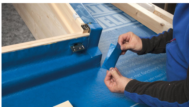
31. Rimuovere il listello portante di aiuto e tagliare i pezzi da incollare sulle staffe di montaggio.
