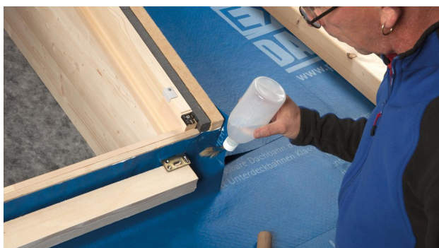
9. Saldare gli angoli precedentemente piegati.
