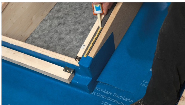
19. Applicare un cordone di 6 mm di ORCON CLASSIC sul telaio.
