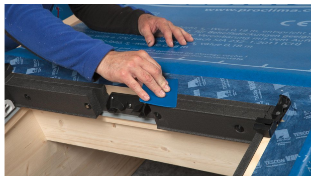
26. Utilizzare TESCON VANA per fissare con praticità le parti applicate.
