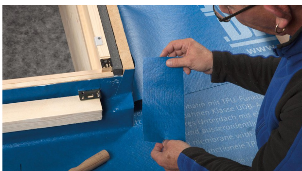
11. Tagliare un pezzo adatto alla copertura dei ritagli nell'angolo del telaio, lungo da 15 a 20 cm ca. e largo da 10 a 12 cm ca.
