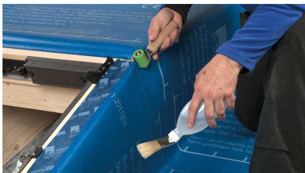
25. Saldare tra loro di lato gli strati di SOLITEX WELDANO 3000.
