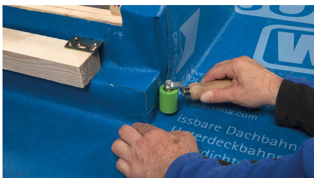
29. Saldare la striscia di SOLITEX WELDANO 3000.
