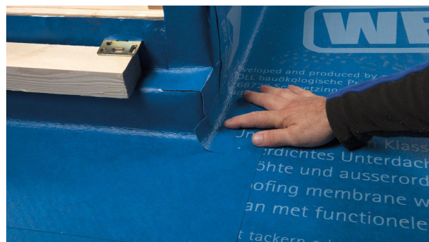
28. Accertarsi di sovrapporre le membrane garantendo lo scarico dell'acqua.
