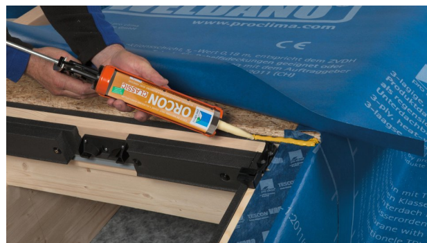
24. Incollare SOLITEX WELDANO 3000 con ORCON CLASSIC sulla parte superiore del telaio della finestra.
