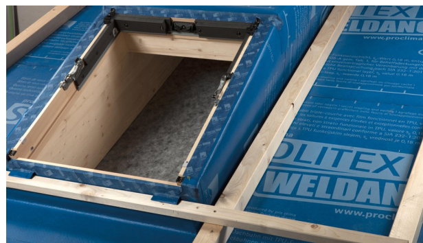
34. Montare controlistellatura e listelli portanti e avvitare le staffe di montaggio. Finito.
