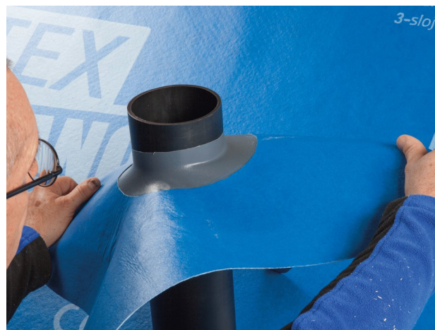
2. Realizzare la giunzione Infilare WELDANO ROFLEX PLUS sul tubo.
