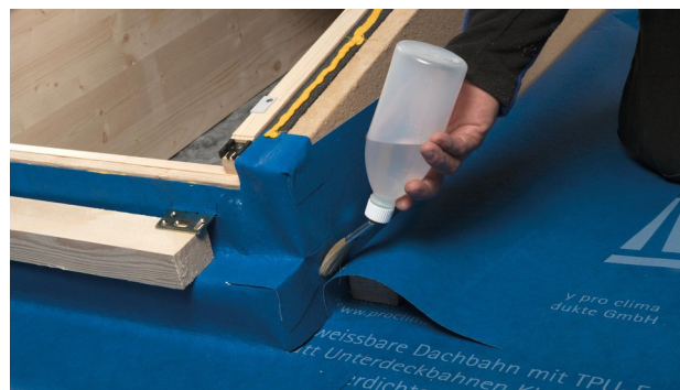
20. Saldare l'area dell'angolo inferiore.
