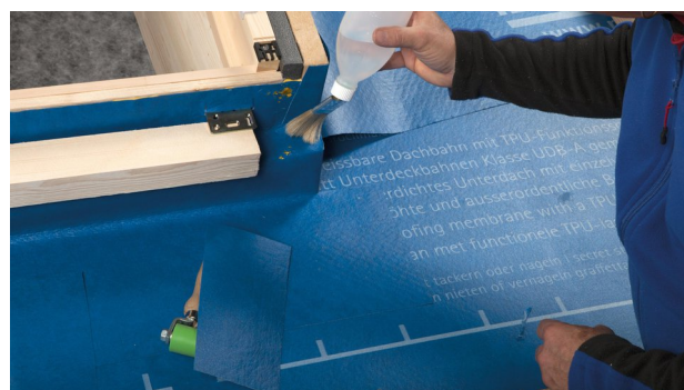
12. Saldare il pezzo nell'angolo sul bordo inferiore del telaio della finestra/di isolamento.
