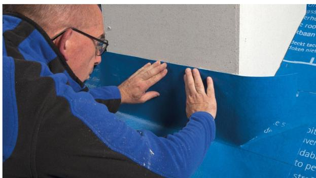
**13b. Bei Steildächern: Anschluss an aufgehende Bauteile (z. B. Schornstein)**
