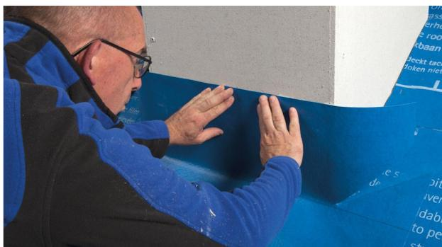
**13b. Bei Steildächern: Anschluss an aufgehende Bauteile (z. B. Schornstein)**
