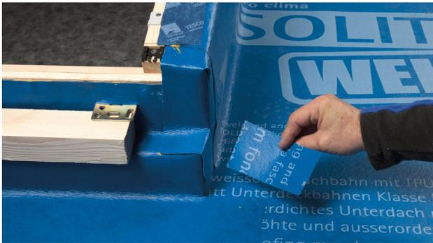
27. Um Schnittkanten im unteren Eckbereich zu überdecken, einen kleinen Streifen SOLITEX WELDANO 3000 ausschneiden und anlegen.
