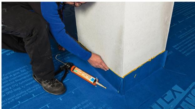
**12b. Bei flach geneigten Dächern: Anschluss an aufgehende Bauteile (z. B. Schornstein)**
