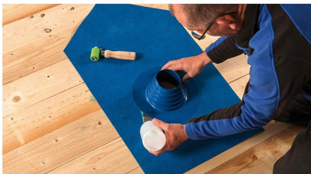
**10d. Bei flachgeneigten Dächern: Anschluss Rohrdurchdringungen**
