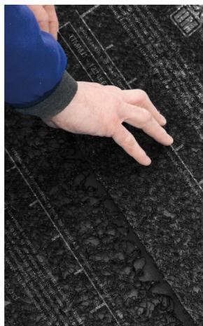
**9. Kopfstoß: Bahn ausrichten und fixieren**
