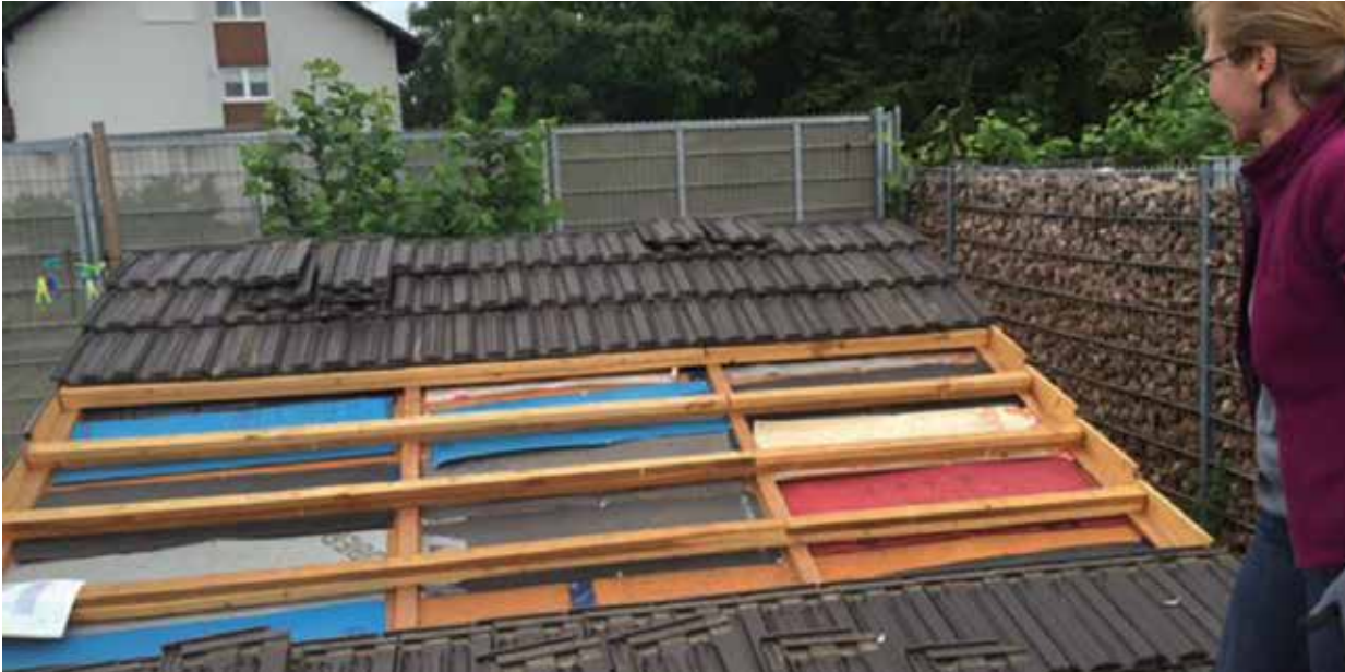
Analyse d'écrans de sous-toiture (pose libre tendue) de différents fabricants 5 ans après la mise en oeuvre
