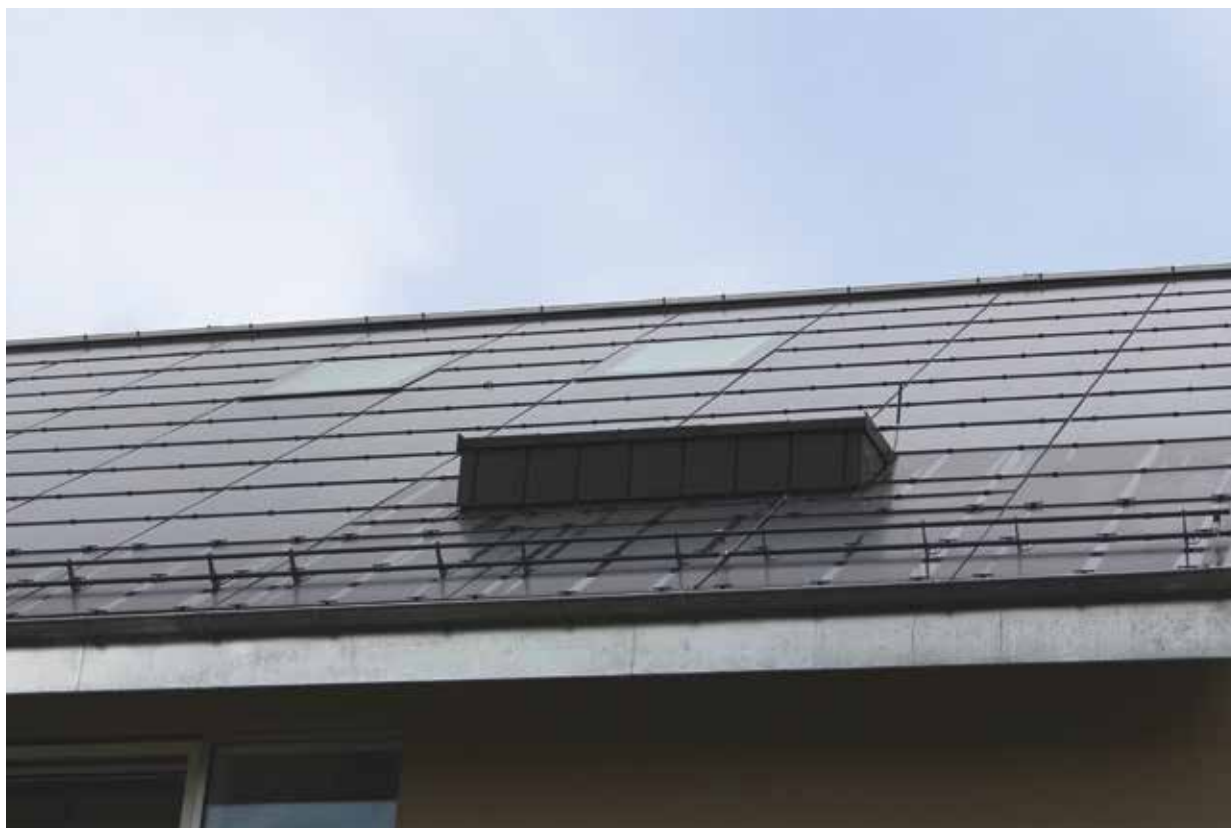
Installation photovoltaïque intégrée, avec sous-toiture MENTO 3000 connect
