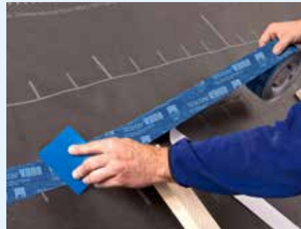
Abb. 5: Verklebung von Nähten und Stößen mithilfe von Klebeband oder von Selbstklebezonen
