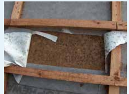
Abb. 31: Schimmelbefall unter mikroporöser Unterdeckbahn – aufgrund von schwachem, passiven Feuchtetransport hat sich die Holzfaserplatte unterhalb der Bahn aufgefuechtet und Schimmelwachstum begünstigt
