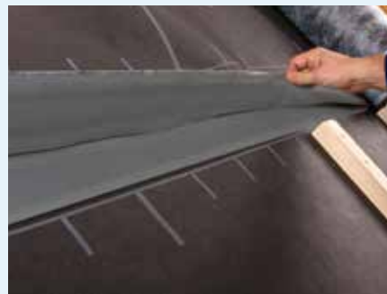
Abb. 42: Bahnüberlappungen mit Selbstklebezonen – die Verklebung erfolgt hier vor ablaufendem Wasser geschützt unter der Überlappung. Die Verklebung durch Kleber funktioniert auch unter widrigen Umständen sicher.
