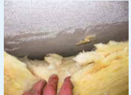
Abb. 30: Wasserfilmbildung bei mikroporöser Unterdeckbahn
