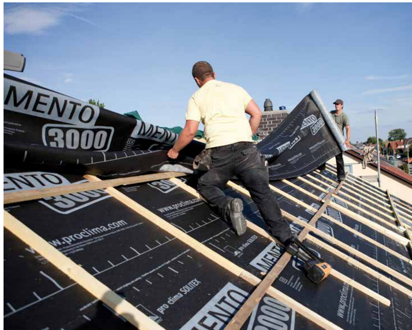
Abb. 1: Moderne Unterdeckbahn als Außendichtung unter späterer Eindeckung
