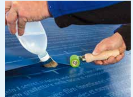
Abb. 21: Verschweißung von Unterdeckbahnen, mittels Quellschweißmittel oder Heißluftföhn werden die Funktionsschichten überlappender Bahnen homogen verschweißt
