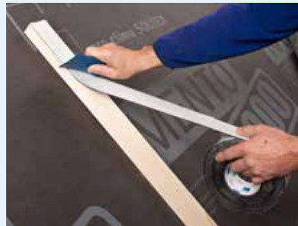
Abb. 6: Abdichtung der Durchdringungen durch Befestigungsmittel der Konterlatte mit Nageldichtband/-masse oder durch nachgewiesene Abdichtungswirkung der Bahn selbst
