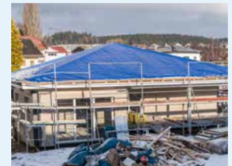
Abb. 2: Abplanen eines Daches
