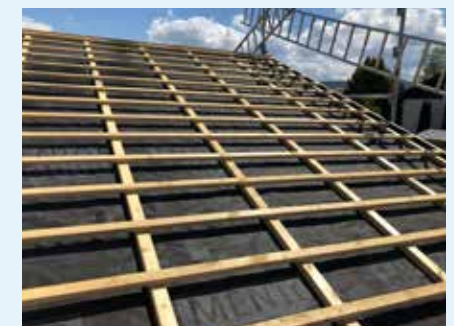
Abb. 4: Regensichernde Zusatzmaßnahme (hier verklebte Unterdeckbahn mit Nagel-dichtband)
