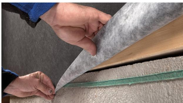
**7. In alternativa: giunzione su sottofondi grezzi o minerali (ad es. solai) con ORCON MULTIBOND**
