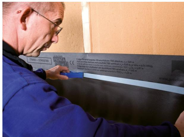
Untergrund reinigen (trocken, staub-, silikon- und fettfrei), Verklebung mit doppelseitigem Klebeband DUPLEX feuchteschutz im unteren Drittel der späteren Überlappung.
