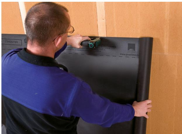
Bahn ausrollen und mit mind. 10 mm breiten und 8 mm langen verzinkten Tackerklammern feuchteschutz im Überlappungsbereich oder in Bereichen, die anschließend durch eine Konterlattung überdeckt werden im Abstand von 10-15 cm befestigen.
