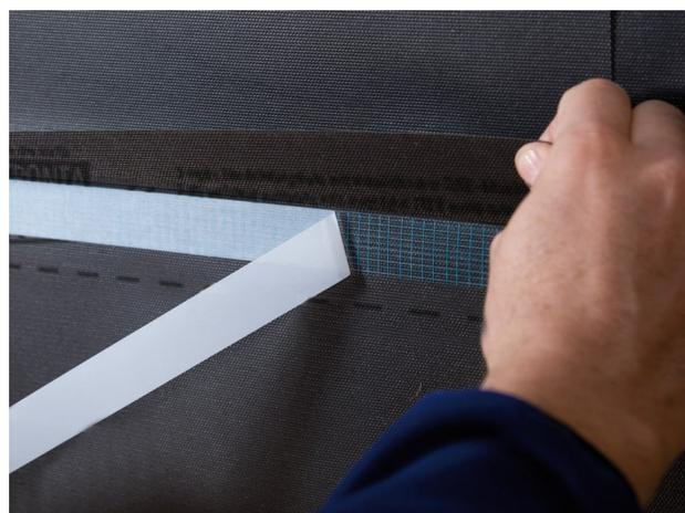
Trennfolie vom DUPLEX Zug um Zug entfernen und überlappende Bahn last- und faltenfrei verkleben.
