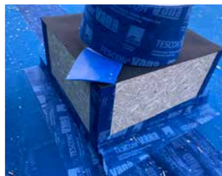
Zur sicheren Abdichtung von Durchdringungen
