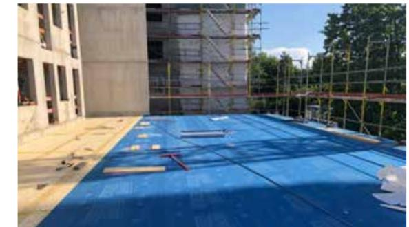
Die vollflächig selbstklebenden Witterungsschutzbahnen der SOLITEX ADHERO-Linie verbinden diese Anforderungen und geben Planern und Verarbeitern ein komplettes System an die Hand mit optimal aufeinander abgestimmten Komponenten:
