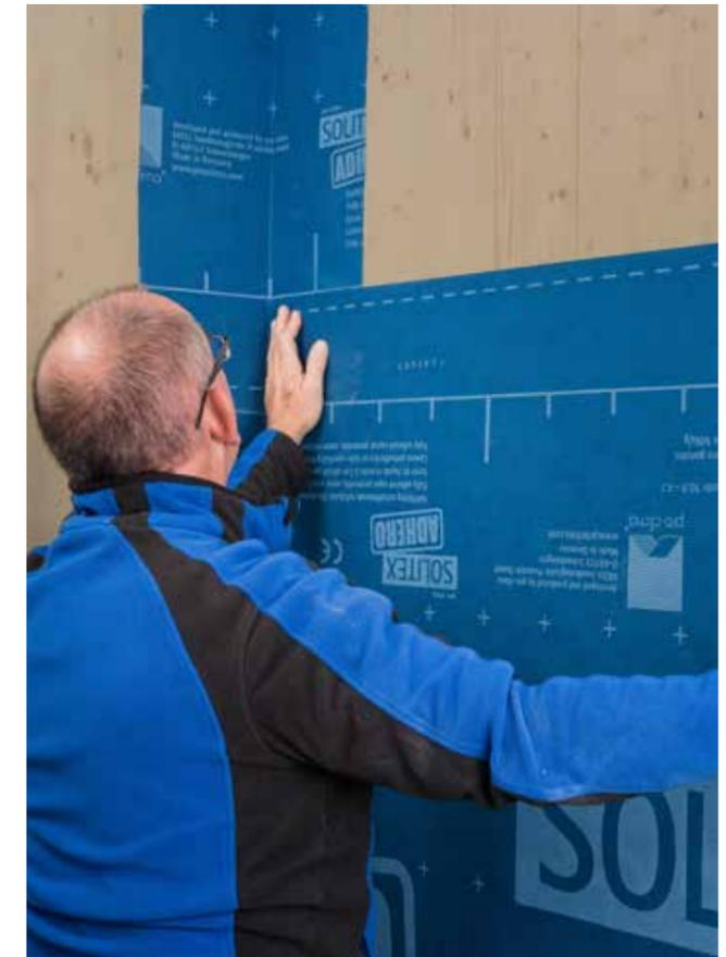
Luftdichtung und Witterungsschutz Wand
