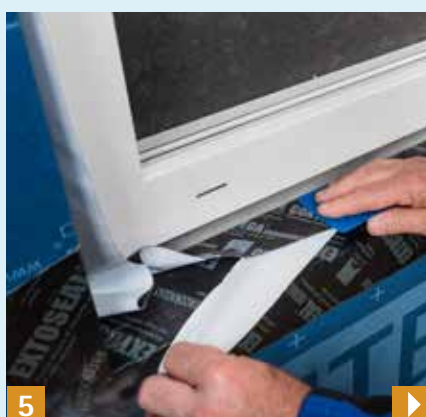
5 Effettuare il raccordo interno ed esterno delle finestre con CONTEGA.
