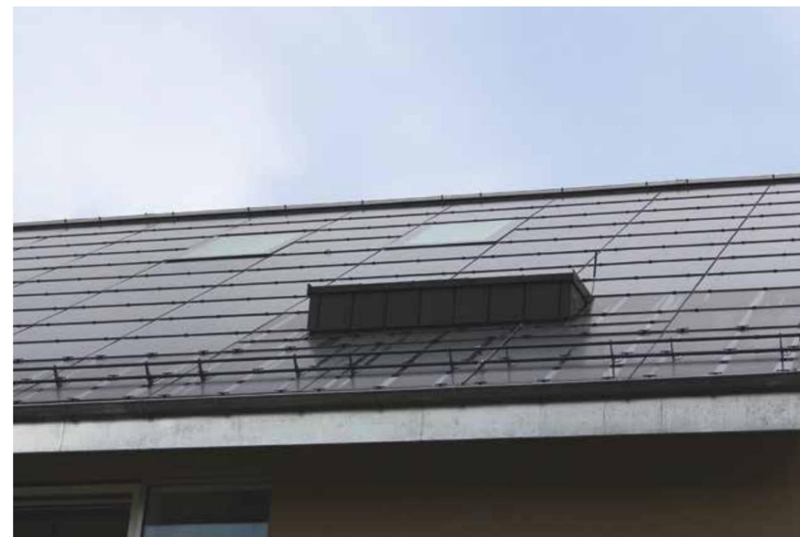
Installation photovoltaïque intégrée, avec sous-toiture MENTO 3000 connect
