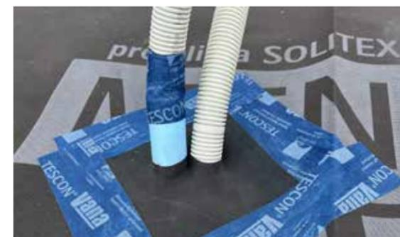
Les manchettes pro clima et le ruban adhésif universel TESCON VANA ont été utilisés pour réaliser l'étanchéité de gaines (ROFLEX 20 multi) ...
