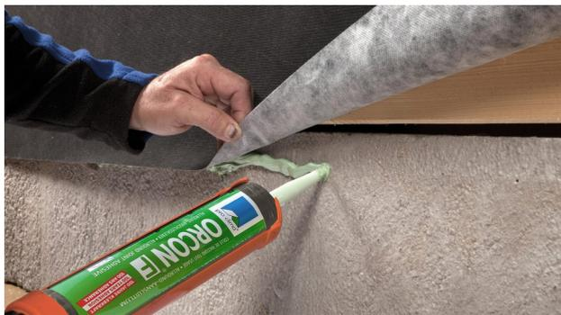
**5. Anschluss an raue oder mineralische Untergründe (z. B. Bodenplatte)**
