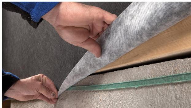
**6. Alternativ: Anschluss an raue oder mineralische Untergründe (z. B. Bodenplatte) mit ORCON MULTIBOND**
