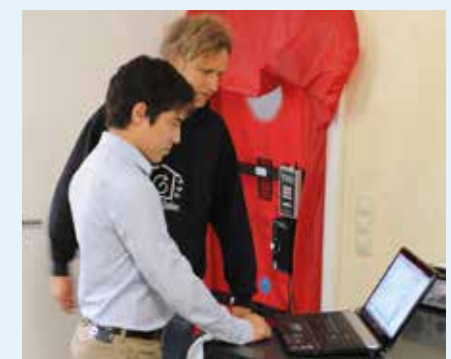
Blower door testing
