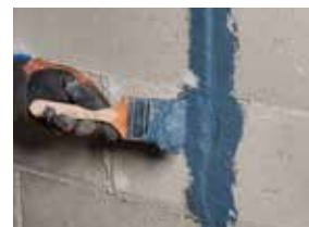
Rebouchage de fissures qu'à 20 mm
