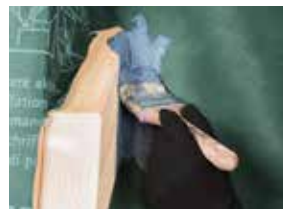
Raccord chevrons / noues avec AEROSANA VISCONN FIBRE et AEROSANA FLEECE
