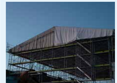
Abb. 3: Einhausen bzw. Notdach
