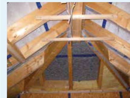
Abb. 32: Hier wurden bei ein und demselben Projekt monolithische SOLITEX-Bahnen (Walm in Bildmitte) und mikroporöse Bahnen (Hauptdachflächen) verbaut; bei identischen Bedingungen: mikroporös = Wasserfilm, monolithisch = trocken
