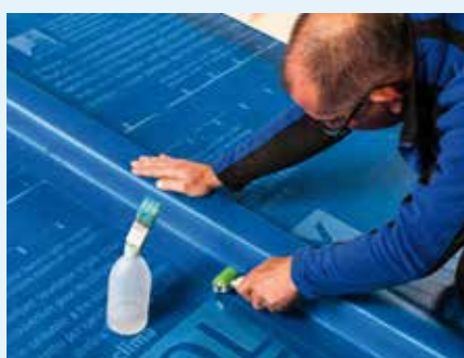
Abb. 19: Nahtgefügte Unterdeckung mit eingebundener Konterlatte – regensichernde Zusatzmaßnahme der höchsten Klasse; diese Maßnahme bietet sehr hohe Regensicherheit, auch bei besonders niedrigen Dachneigungen
