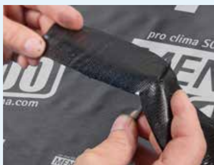
Abb. 45: Fließfähiges Butyl zieht sich entlang des Nagelschaftes hinein in den Untergrund und dichtet dort direkt ab.
