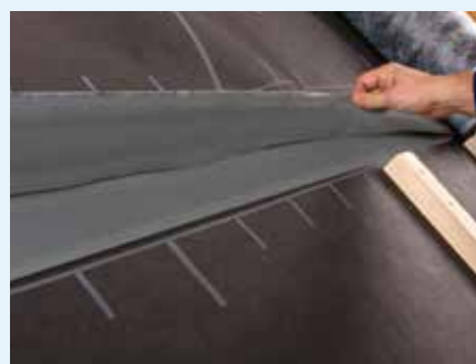
Abb. 42: Bahnenüberlappungen mit Selbstklebezonen – die Verklebung erfolgt hier vor ablaufendem Wasser geschützt unter der Überlappung. Die Verklebung durch Kleber funktioniert auch unter widrigen Umständen sicher.
