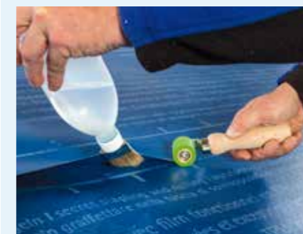
Abb. 21: Verschweißung von Unterdeckbahnen, mittels Quellschweißmittel oder Heißluftföhn werden die Funktionsschichten überlappender Bahnen homogen verschweißbar
