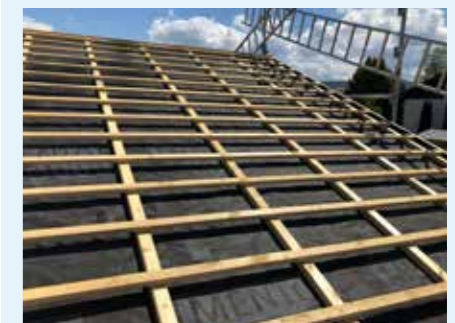
Abb. 4: Regensichernde Zusatzmaßnahme (hier verklebte Unterdeckbahn mit Nagel-dichtband)
