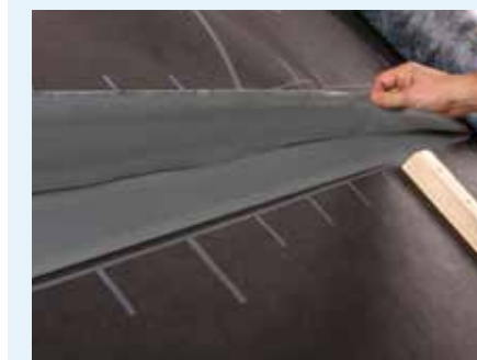
Afb. 41: Folieoverlappen met geïntegreerde tape – de lijmverbinding zit onder de overlapping en is tegen wegstromend water beschermd. De verlijming door hechtlaag-tegen-hechtlaag is ook onder ongunstige omstandigheden betrouwbaar.
