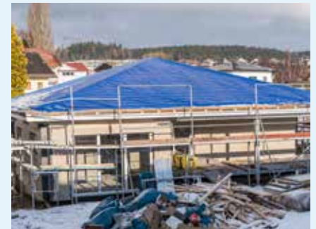
Afb. 2: Afdekken van een dak
