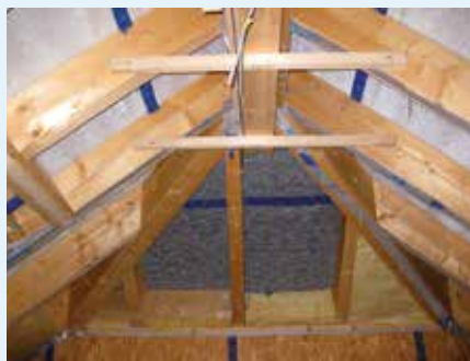
Afb. 31: Hier werden bij hetzelfde project monolithische SOLITEX-folies (dakschild in het midden van de foto) en microporeuze folies (hoofddakvlakken) aangebracht; bij identieke omstandigheden: microporeus = waterlaagje, monolithisch = droog.
