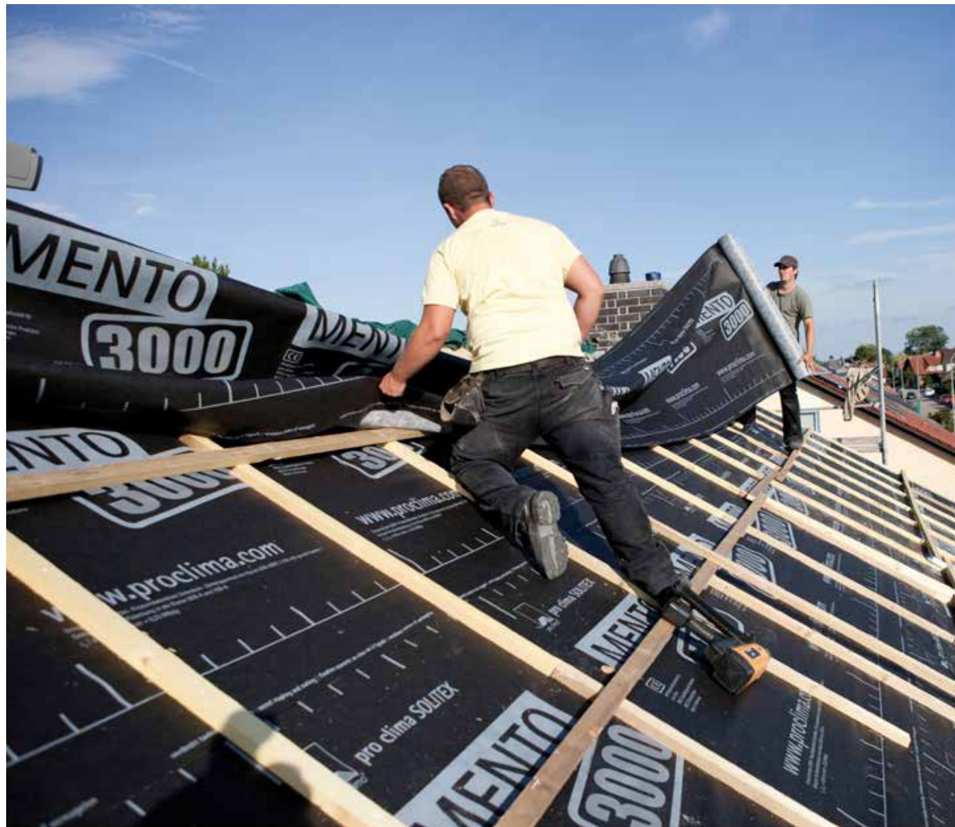
Afb. 1: Moderne dakfolie als winddichting onder de latere dakbedekking
