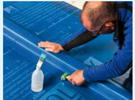
Afb. 18: Gelaste dakfolie met geïntegreerde tengellat – extra maatregel die een zeer goede bescherming biedt tegen regen, ook bij daken met een bijzonder kleine hellingshoek.
