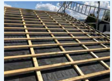
Afb. 4: Verlijmd dakfolie met nageldichting
