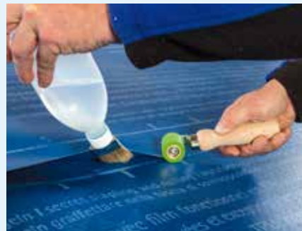
Afb. 20: Lassen van dakfolies. De functionele lagen van overlappende folies worden homogeen gelast met een zwelasmiddel of een heteluchtpistool.
