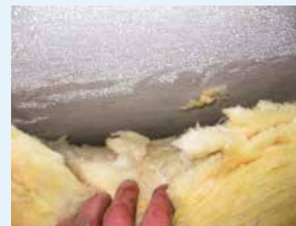
Afb. 29: Vorming van een waterlaagje bij microporeuze dakfolie.
