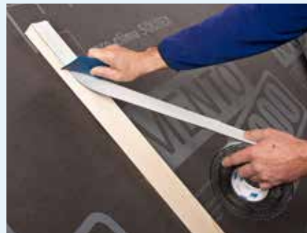
Afb. 6: Afdichting van gaten van tengellatnagels of -schroeven met nageldichtingsband of -massa, of door de aangetoond zelfdichtende werking van de folie zelf.
