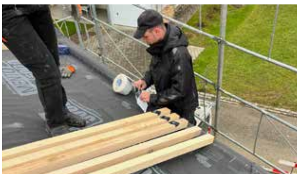
Les patches adhésifs TESCON NAIDECK mono patch servent de taquets d'étanchéité entre les contre-lattes ...
