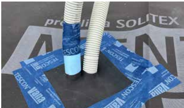
Les manchettes pro clima et le ruban adhésif universel TESCON VANA ont été utilisés pour réaliser l'étanchéité de gaines (ROFLEX 20 multi) ...
