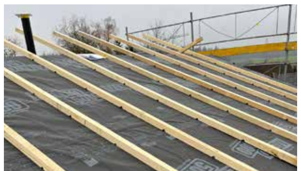
... und der SOLITEX MENTO 5000 connect Unterdachbahn
