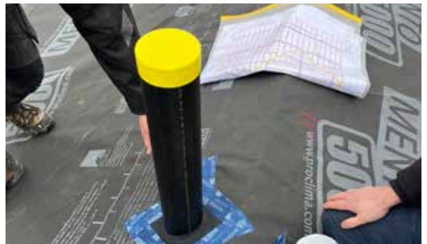
... und Dunstrohre (mit ROFLEX 100) abzudichten
