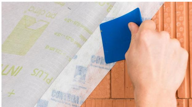
**9. Raccord à des supports apparents**
