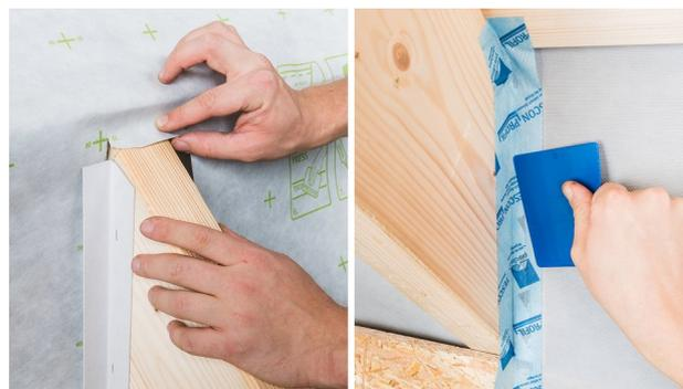
**10b. Raccord en angle de la membrane avec appui**
