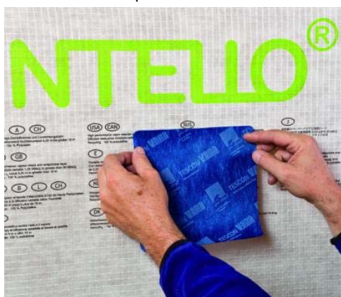
Figure 9 : colmatage des endommagements avec TESCON VANA patch ou TESCON VANA 200 mm
