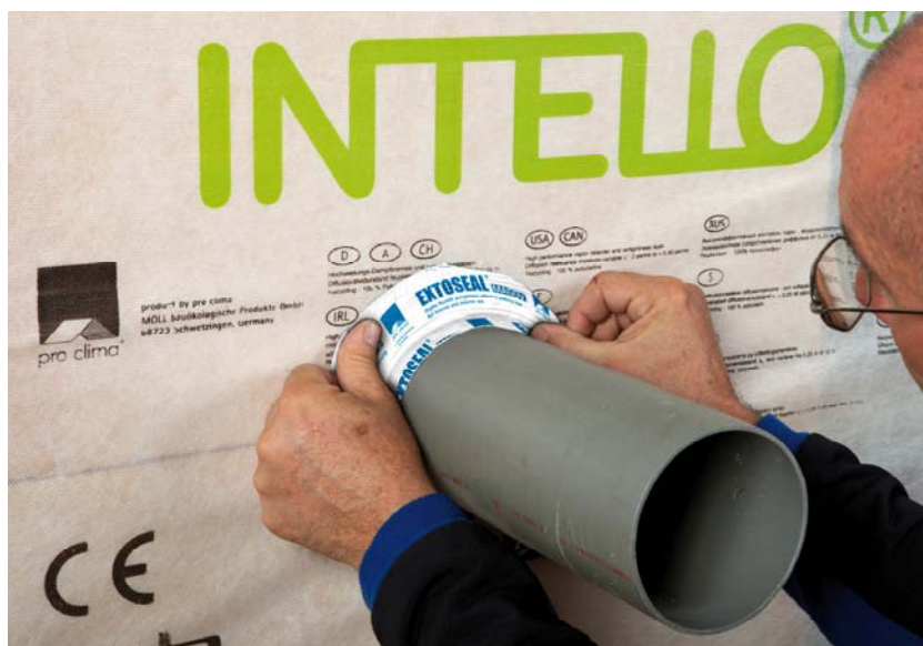
Figure 8 : Collage de la manchette EXTOSEAL Magov sur la membrane INTELLO / INTELLO PLUS
