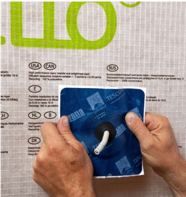
Figure 29 : Collage de la manchette KAFLEX sur la membrane INTELLO / INTELLO PLUS
