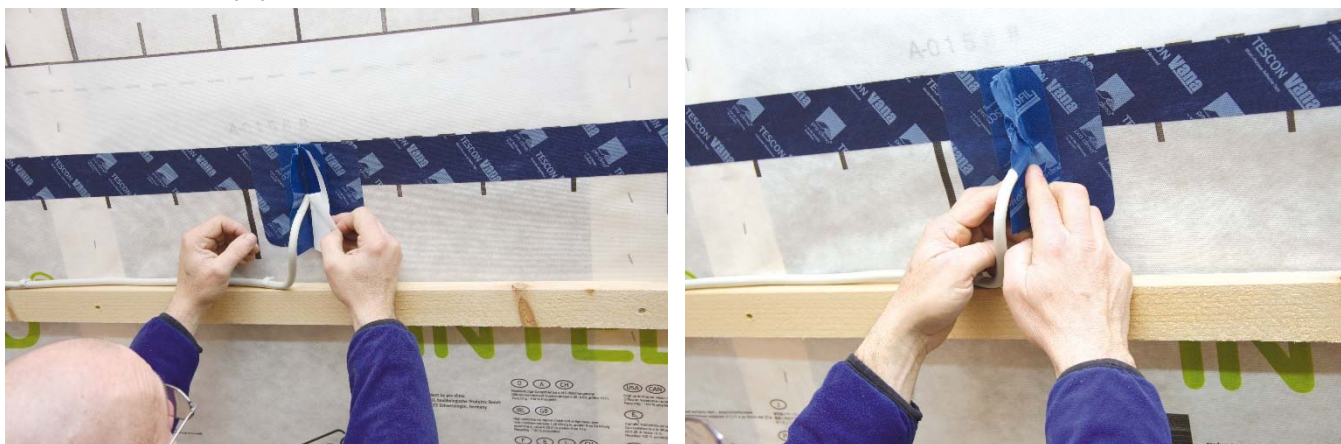
Figure 6 : Retirer le papier transfert et maroufler
