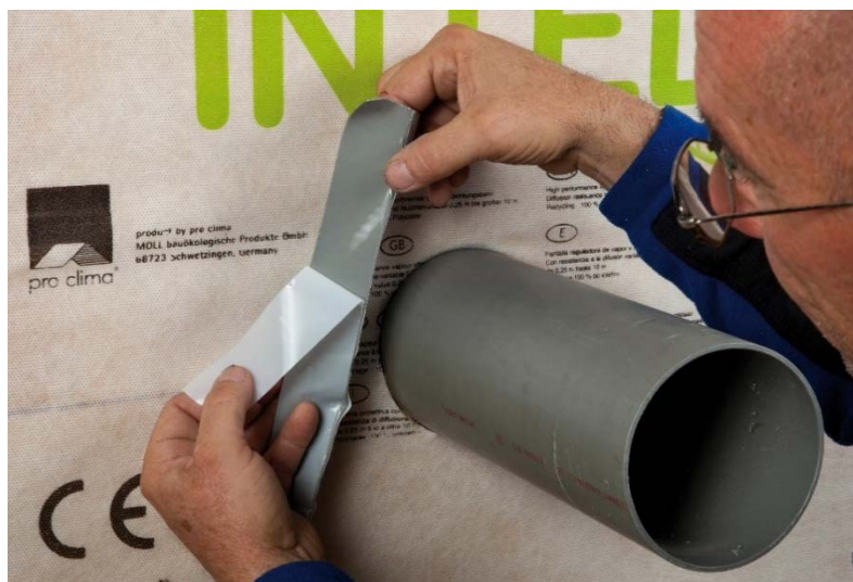
Figure 33 : Collage de la manchette EXTOSEAL Magov au conduit
