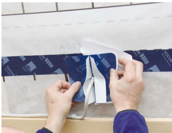
Figure 5 : Mise en œuvre de la manchette Kaflex Post
