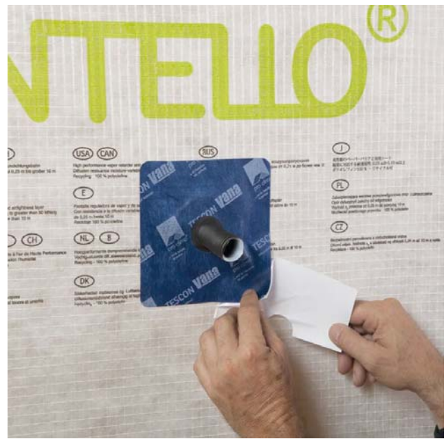
Figure 30 : Mise en place de la manchette ROFLEX 20
