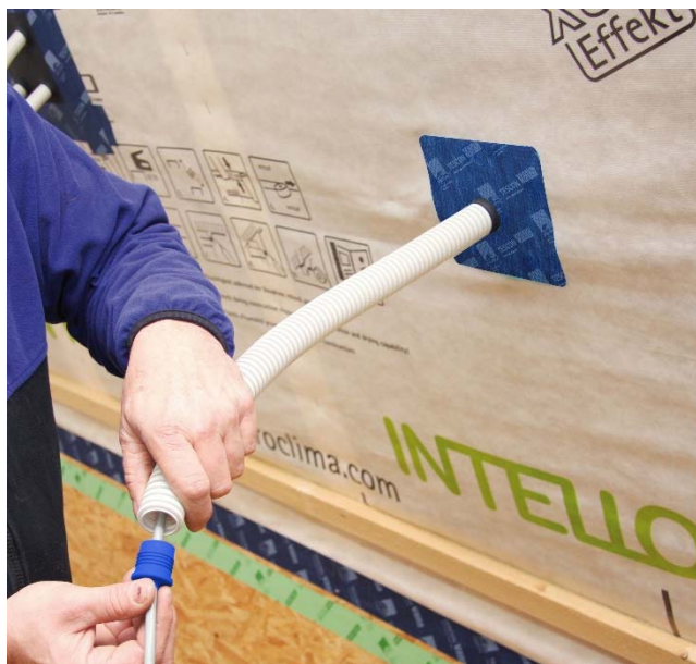
Figure 7 : Mise en place du bouchon STOPPA
