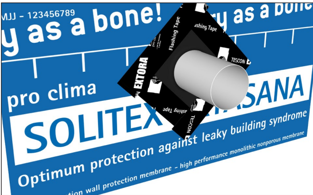
27. 贴覆TESCONEXTORA® 沿整个密封套逆时针缠绕TESCON EXTORA®,确保上层压下层。
