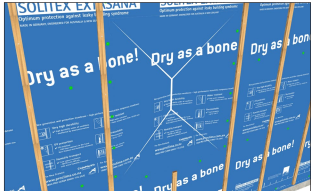
15. 预备窗洞口 在窗洞侧壁处将膜裁成四翼，以便贴入侧壁。
