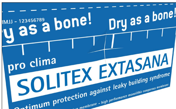
23. 为管道穿透开孔 沿横向与纵向轴开四条缝，仅略大于管道直径。
