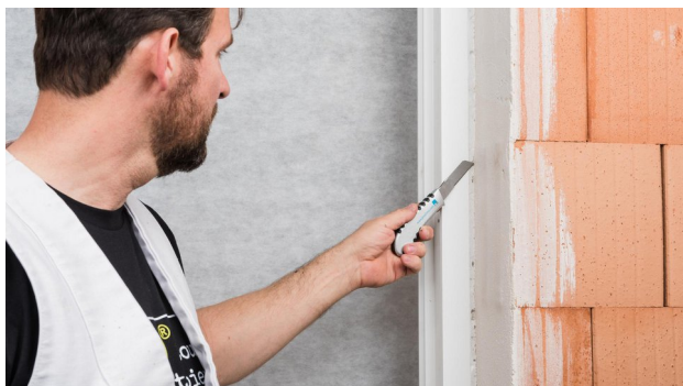
3. Couper le matériau isolant
