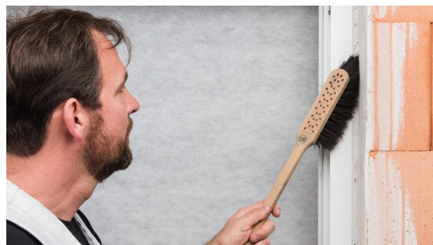
2. Vorbereiten Untergründe abfegen, ggf. absaugen und abwischen.
